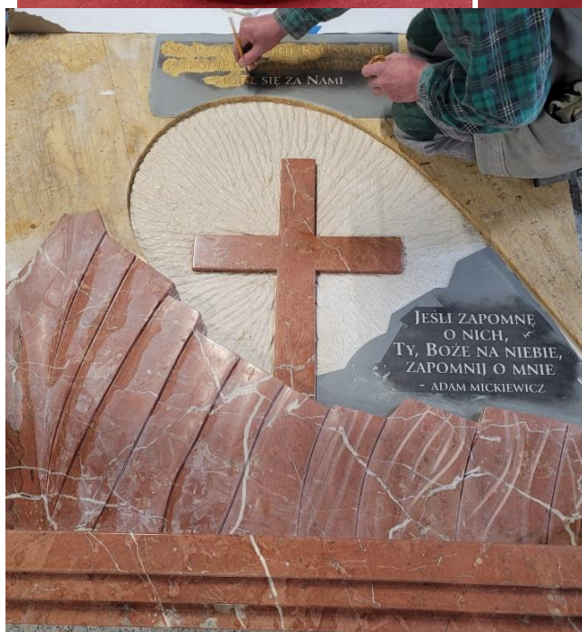
W trakcie wykonywania ...
